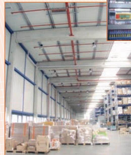
Dank der sehr schnellen Reaktionsfähigkeit der SBM-Strahlungsheizung ist die **Aufheizzeit sehr kurz** (z.B. nach Öffnen und Schließen der Hallentore). Die Temperaturmessung erfolgt durch spezielle Strahlungsfühler, die Temperatureauswertung über **microprozessor-gesteuerte SBM-Regelmodule**. Die Regelmodule ermitteln aus der gemessenen Luft- und Strahlungstemperatur die (bei Strahlungsheizungen erhöhte) Empfindungstemperatur. Diese wird als Führungsgröße verwendet.
