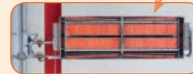
Es wurden **86 SBM-Hochleistungs-Hellstrahler mit je 30 kW Leistung** installiert. Die **Gesamtleistung von 2.580 kW** ist auf **8 Hallen-Bereiche** aufgeteilt worden, welche vollautomatisch durch 8 digitale SBM-Strahlungsregler auf die jeweiligen Temperaturniveaus geregelt werden können. Das Heizsystem wird **2-stufig betrieben**, d.h. 50% Leistung - 100% Leistung. Daher kann es sehr schnell auf jede Temperaturveränderung reagieren.
